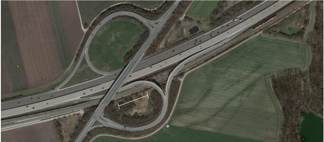
Abb. 6: Anschlußstelle Freising Süd (Google-Luftbild)
