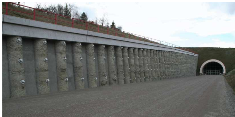
Abb. 8: Aufgelöste Bohrpfahlwand mit Spritzbetonausfachung, Rückverankerung und Kopfbalken an der ICE-Strecke Nürnberg - Erfurt Quelle: Wikipedia, Tunnel Augustaburg
